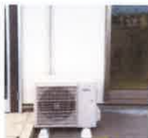
4. 外機取付 (完成)
